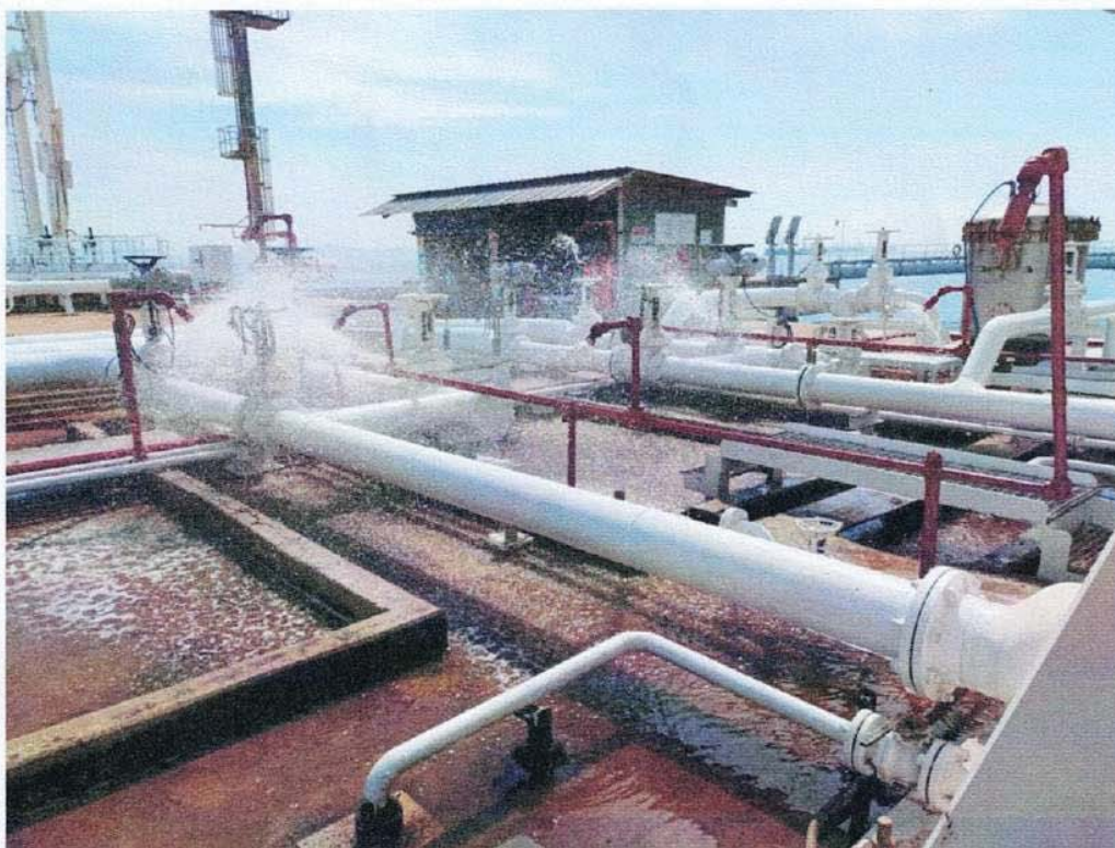
STT 7 พนักงาน Operation เปิดระบบ Delux System ฉีดน้ำหล่อเลี้ยง Valve และระบบท่อทาง ที่ท่า 2
