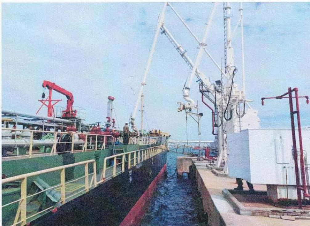
STT 6 พนักงาน Operation ประจำท่า 2 ถอดและเก็บ Loading Arm ที่ต่อกับ Manifold เรือ
