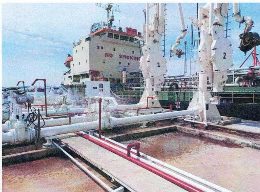
STT 8 พนักงาน Operation เปิดระบบ Delux System ฉีดน้ำหล่อเลี้ยง Valve และระบบท่อทาง ที่ท่า 2
