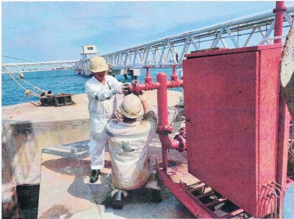
STT 15 จันท.เรือ ขอดต่อระบบ Ship Shor Conect เพื่อใช้น้ำดับเพลิงจากท่าเรือ
