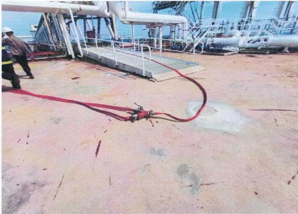
STT 13 จนท.ทีมดับเพลิง ต่อระบบสายดับเพลิงและหัวฉีดน้ำพร้อมทำการฉีดช่วยเหลือนท่าเรือ
